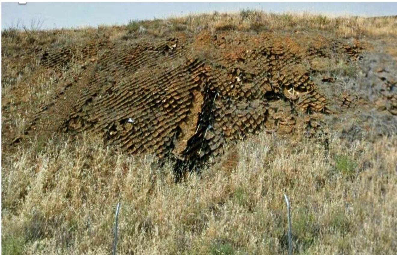
*Fallo generalizado de la “revegetación con plantas autóctonas” en la restauración de una importante escombrera minera en España que ha desarrollado una intensa erosión y ha expuesto y dañado las capas del sellado subyacente (geoceldas, geocompuesto drenante, capa de polietileno, etc.). Presupuesto de la restauración arruinado por la deficiente revegetación: ¡8,5 millones de euros!*
