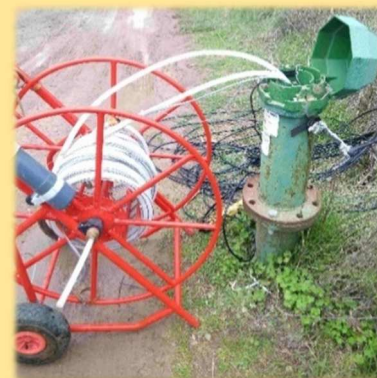
Pompage au forage P4 La Balme
