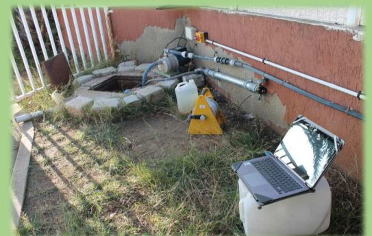
Équipement au forage S12 (école de Balaruc)
