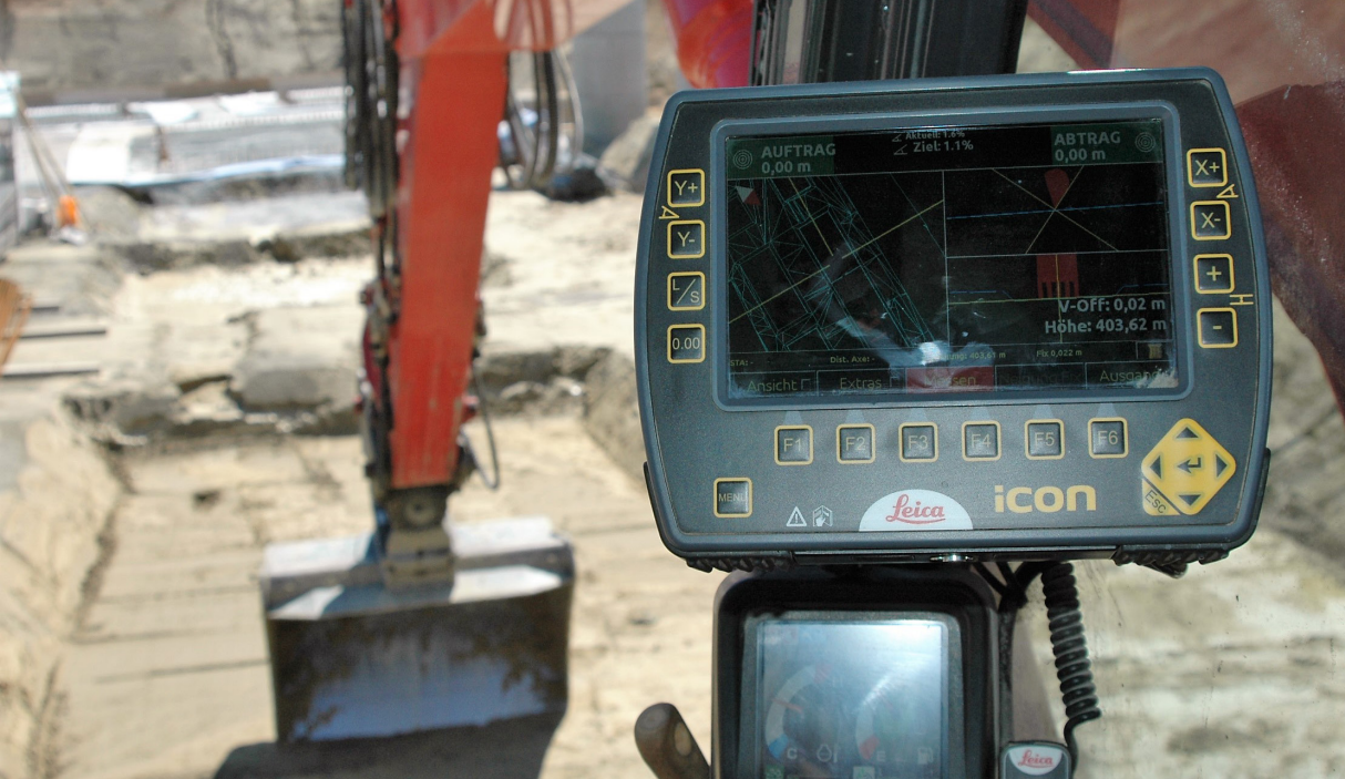
3D-Daten aus Allplan Add-On Baugrube für die Maschinensteuerung auf der Baustelle
